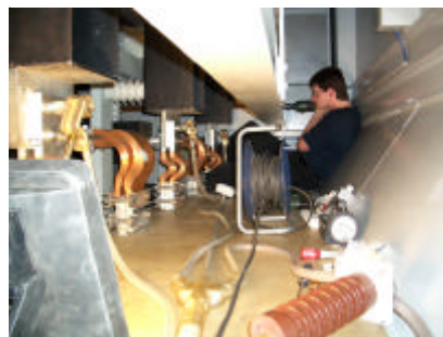
Installation de capteurs sur site
