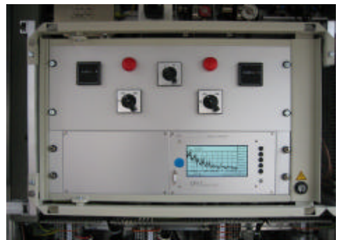
SPECmonitor dans un rack 19 pouces
